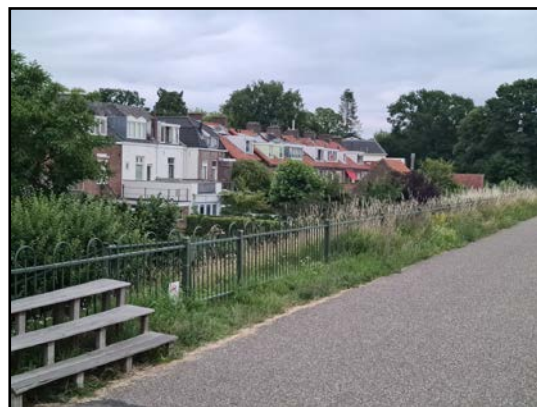
Afbeelding 6: Achterzijde huizen aan Havenstraat
