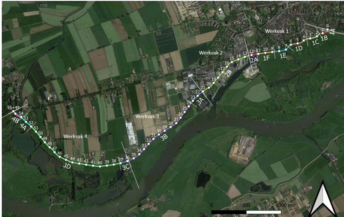
Afbeelding 2.1 Werken in werkvakken tijdens de aanlegfase
