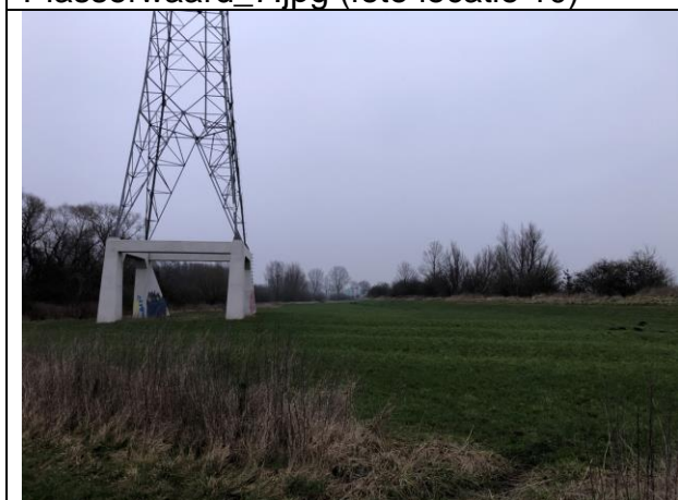
Plasserwaard_9.jpg (foto locatie 12)
