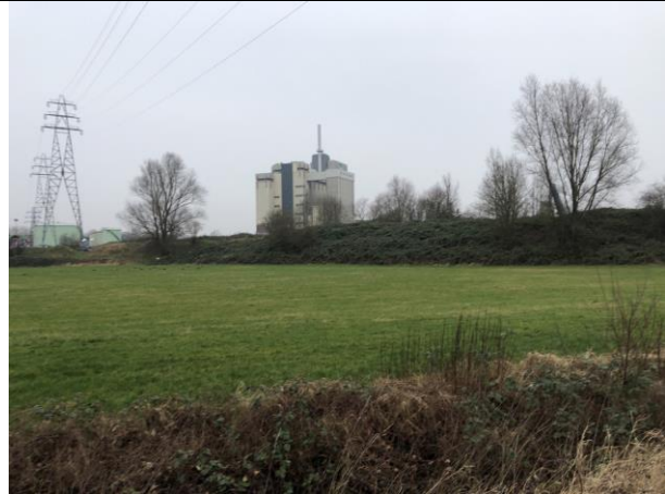
Bovenste_polder_west_4.jpg (foto locatie 28)
