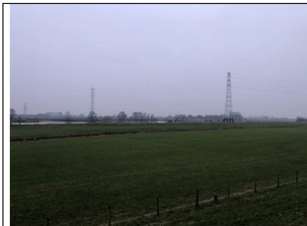
Plasserwaard_7.jpg (foto locatie 10)
