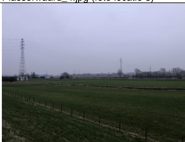
Plasserwaard_6.jpg (foto locatie 10)
